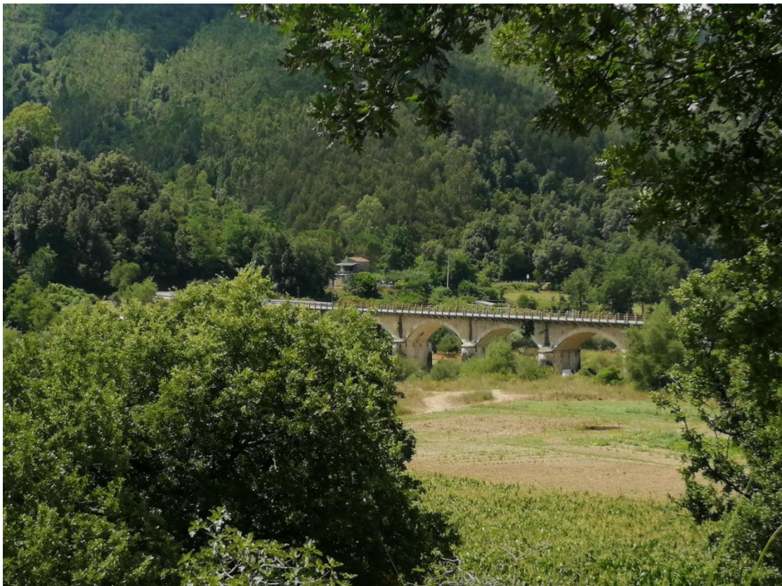
FOTO N°8: La foto riporta il ponte che attraversa la fiumara "Selva dei Santi" che collega l'abitato di Omignano con la frazione Casino Lebano oltrechè i paesi limitrofi
